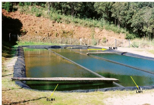
**Fig. 3.** Estações de amostragem na lagoa de maturação 1 (LM1): (ELM1: entrada da lagoa de maturação 1; SLM1: saída da lagoa de maturação 1), da ETE-UCS, Caxias do Sul, RS. (fonte: Instituto de Saneamento – UCS, 2005).
